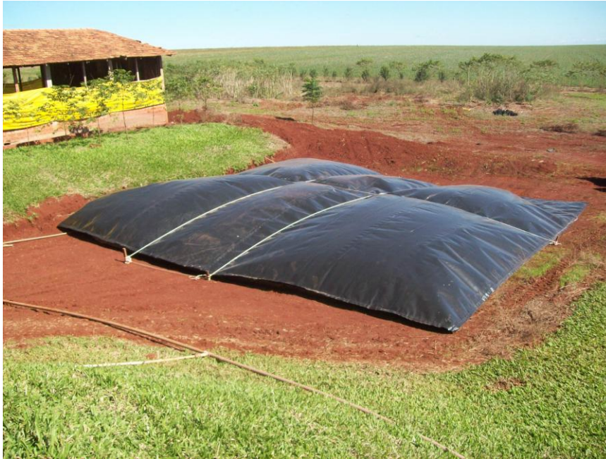
Figura 4: Balão de armazenamento
