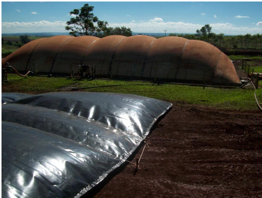
Figura 5: Biodigestor e balão de armazenamento
