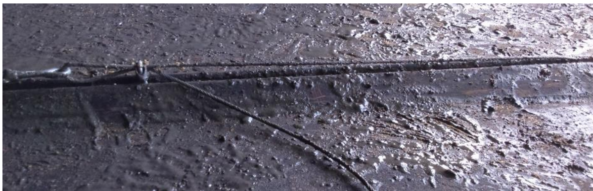
Figura 45: Cabo de aço exposto
