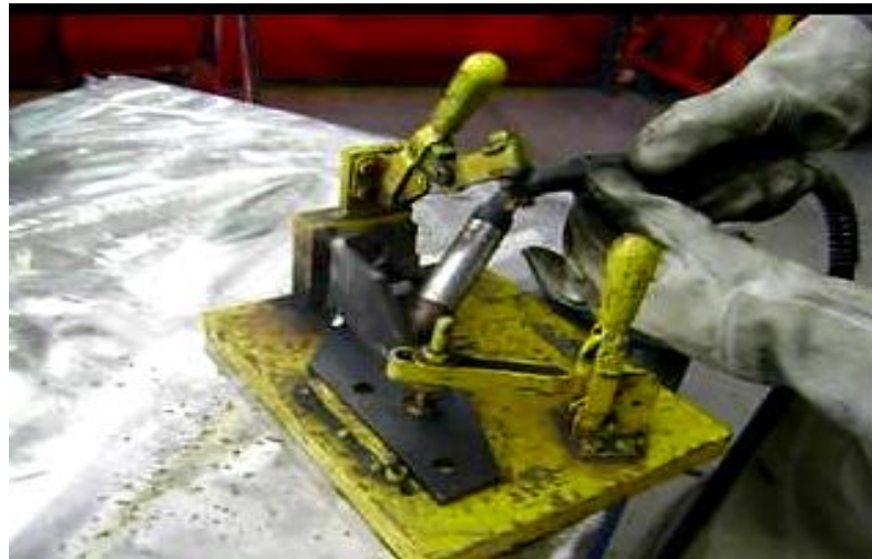
Figura 15 – Soldagem das partes com auxílio do dispositivo.
