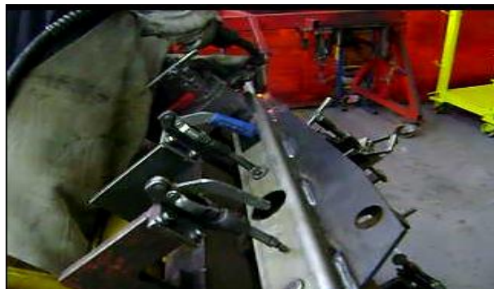
Figura 18 - Soldagem das partes com auxílio do dispositivo.
