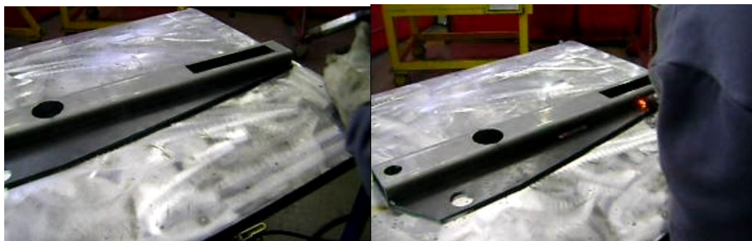
Figura 22 - Soldagem das partes sem auxílio do dispositivo.
