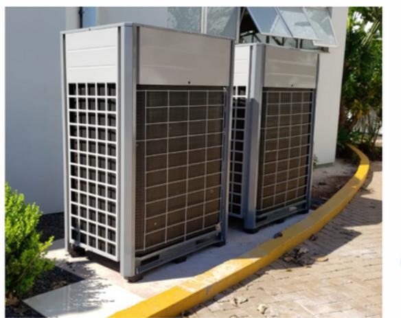
Já no prédio EP, foi substituído todo o sistema de ar condicionado pelo sistema VRF. As principais características deste sistema são a alta eficiência energética, alto nível de controle e automação, baixo nível de ruído e alta durabilidade, que contribuem para o bem-estar dos estudantes.
