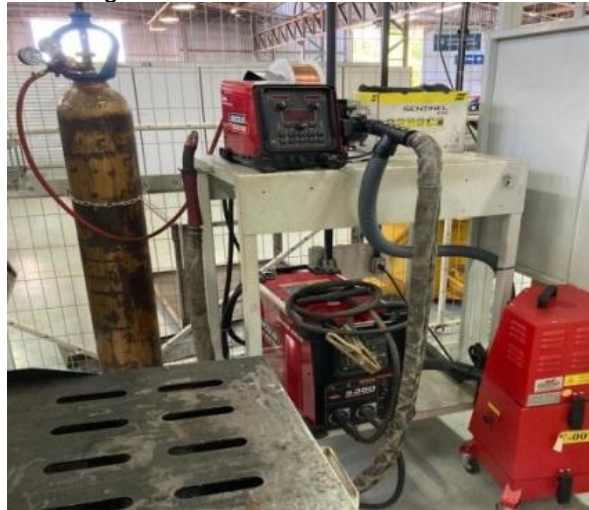
Figura 18 – Equipamento de soldagem.
